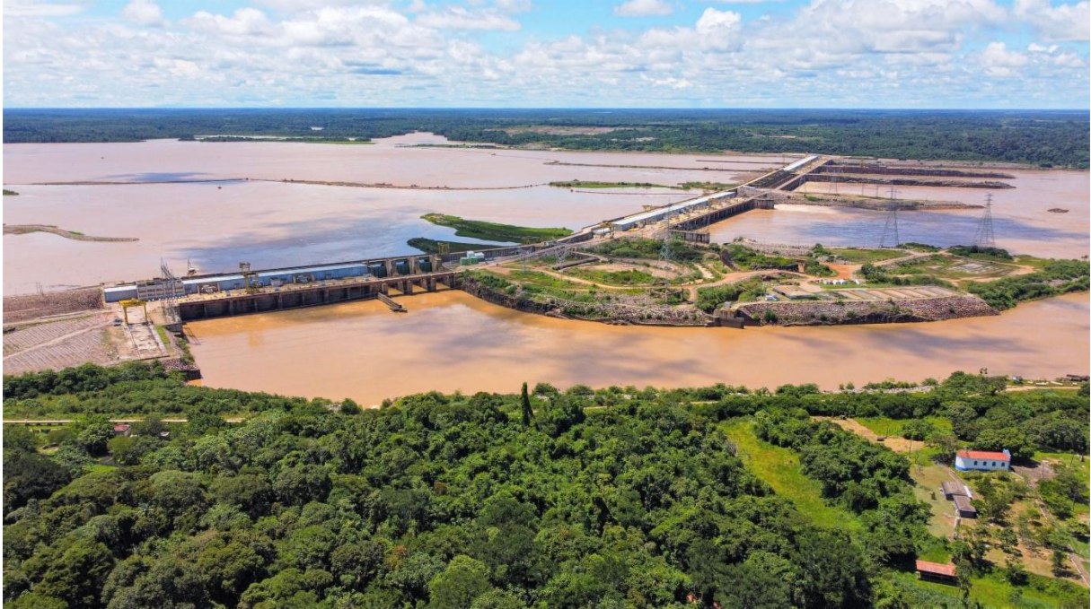
Figura 1 – Vista geral da barragem da UHE Santo Antônio
